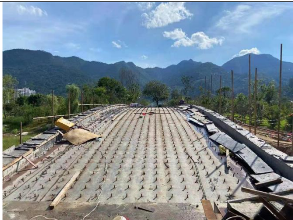
典型现场探伤工作场所-桥梁
