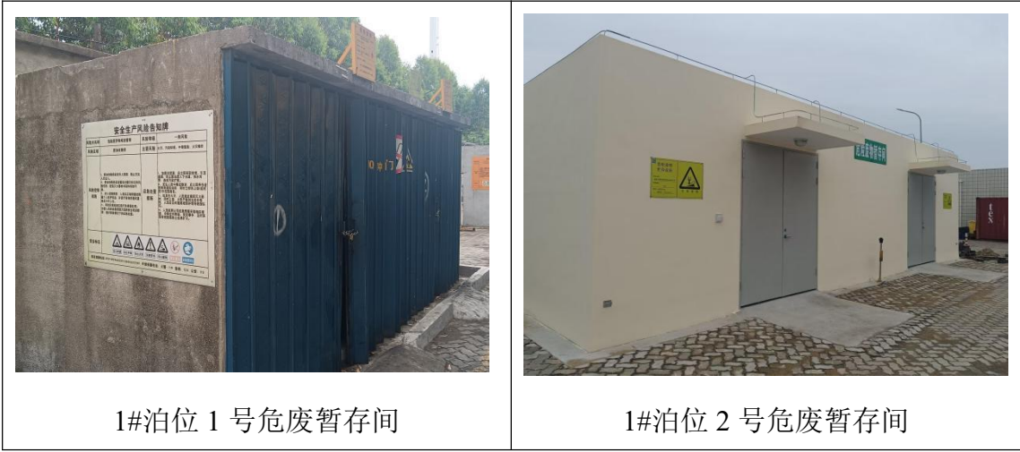
图 5.2-1 1#泊位危废暂存间现状
