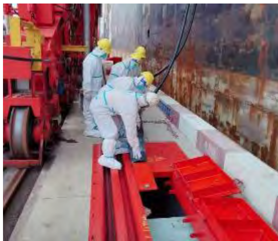
图 2.2-24 岸电接电装置布置图
